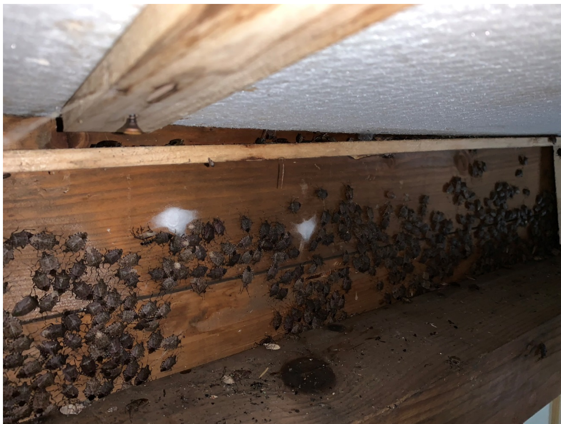
Figura 5 Sotto pannelli di polistirolo appoggiati alla parete di una casetta di legno
